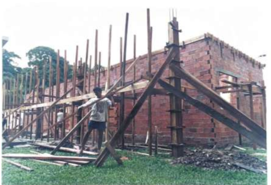
Figura 4 - Construção do Labta
