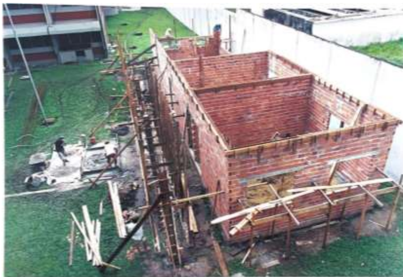
Figura 5 - Construção do Labta
