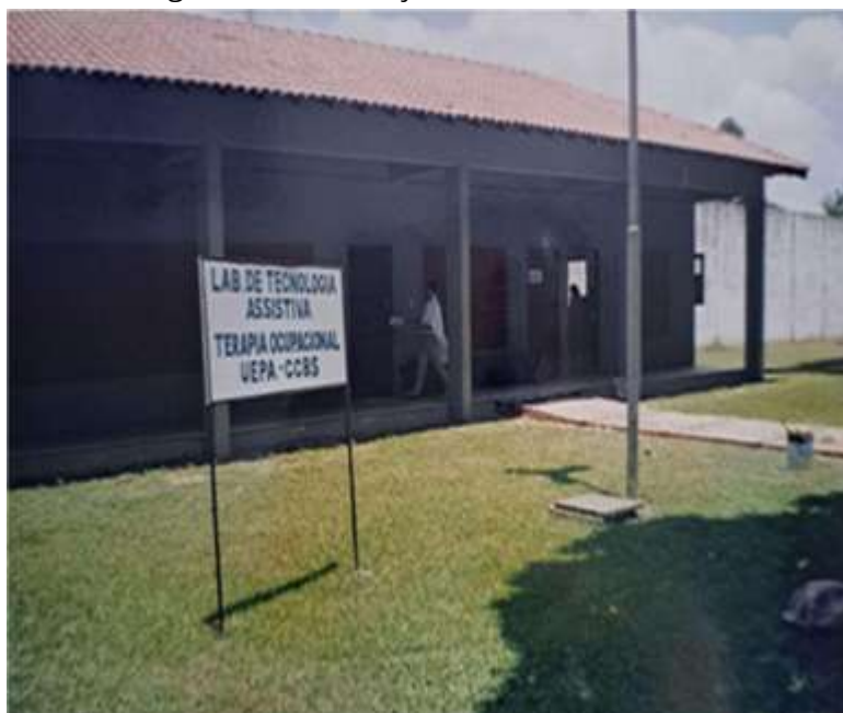
Figura 6 - Construção do Labta concluída
