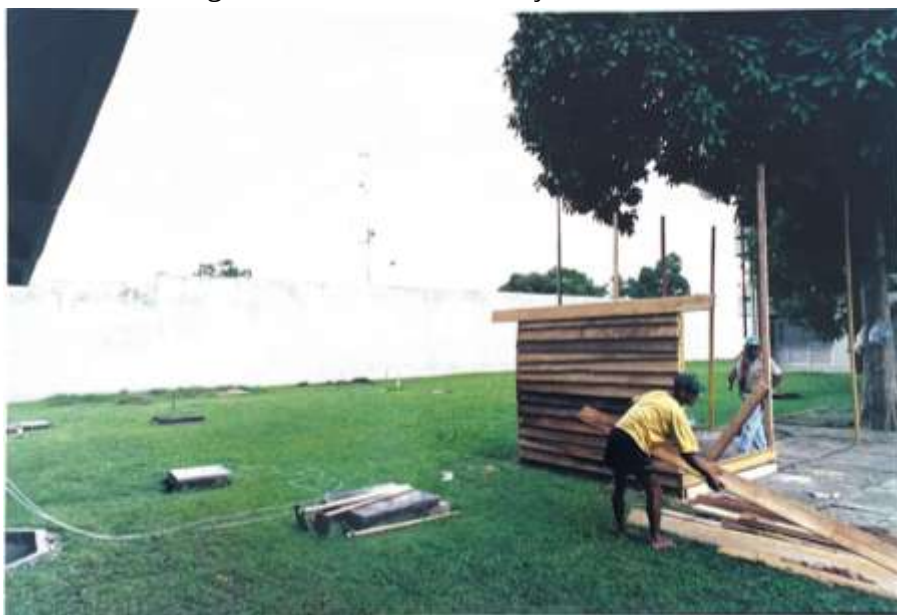
Figura 3 - Início da construção do Labta
