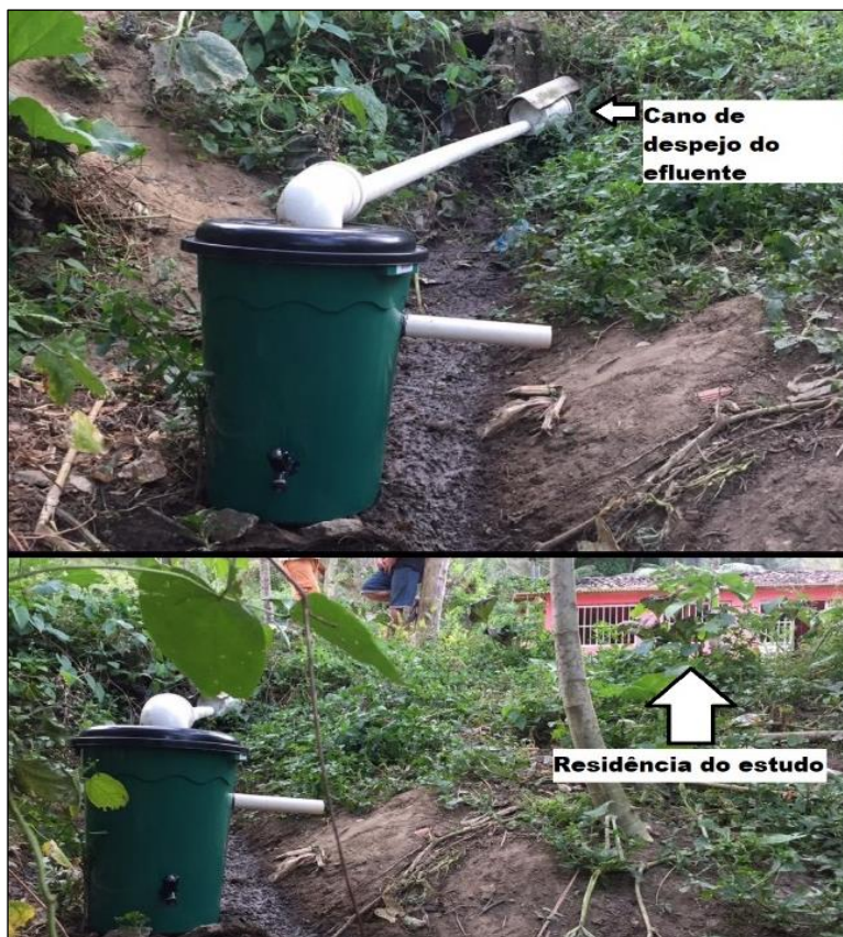
Figura 5: Sistema de captação do efluente doméstico.
